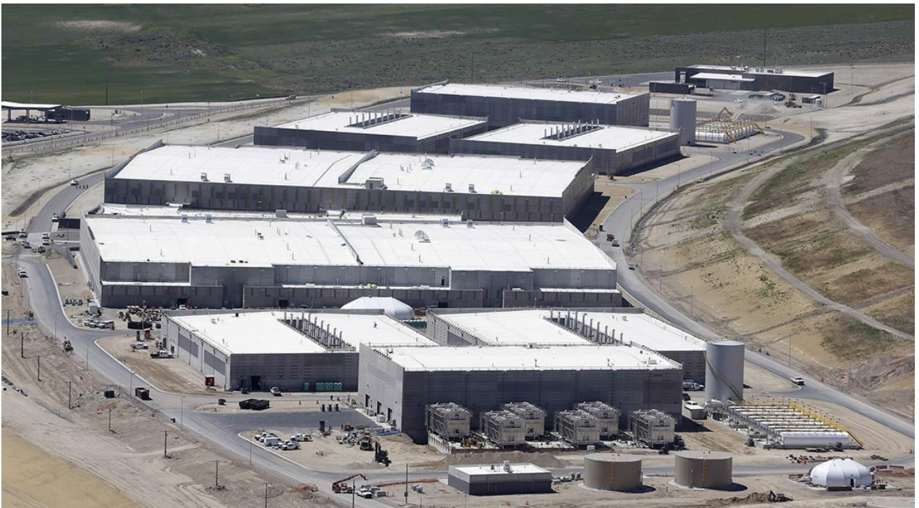
Bild 1: Das 2 Mrd. Dollar NSA Daten-Zentrum in Bluffdale, Utah, USA (Quelle: businessinsider.com )
